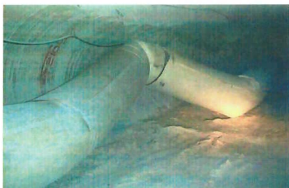
Figura 29 – Estrangulamento de dutos Fonte: Arquivos UOTV
